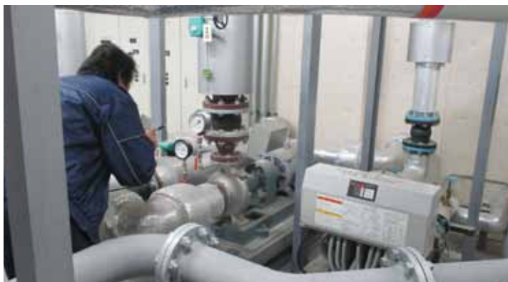
給排水設備点検
